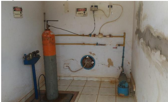
Figura 35 - Bomba cloradora
