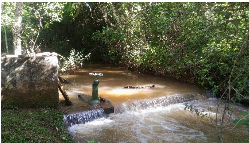
Figura 28 – Sistema de captação de água no Ribeirão Santa Bárbara
