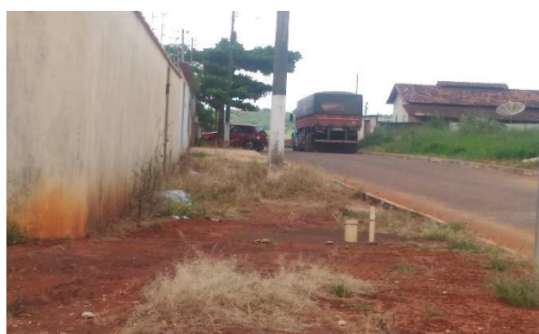
Figura 46 - Fossa Negra residencial
