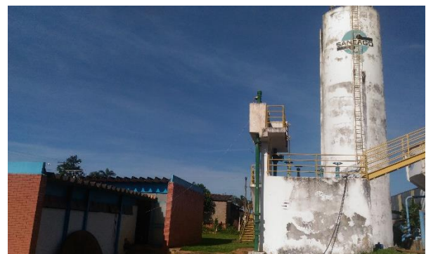
Figura 30 - Escritório da Estação de Tratamento de água de Orizona.
