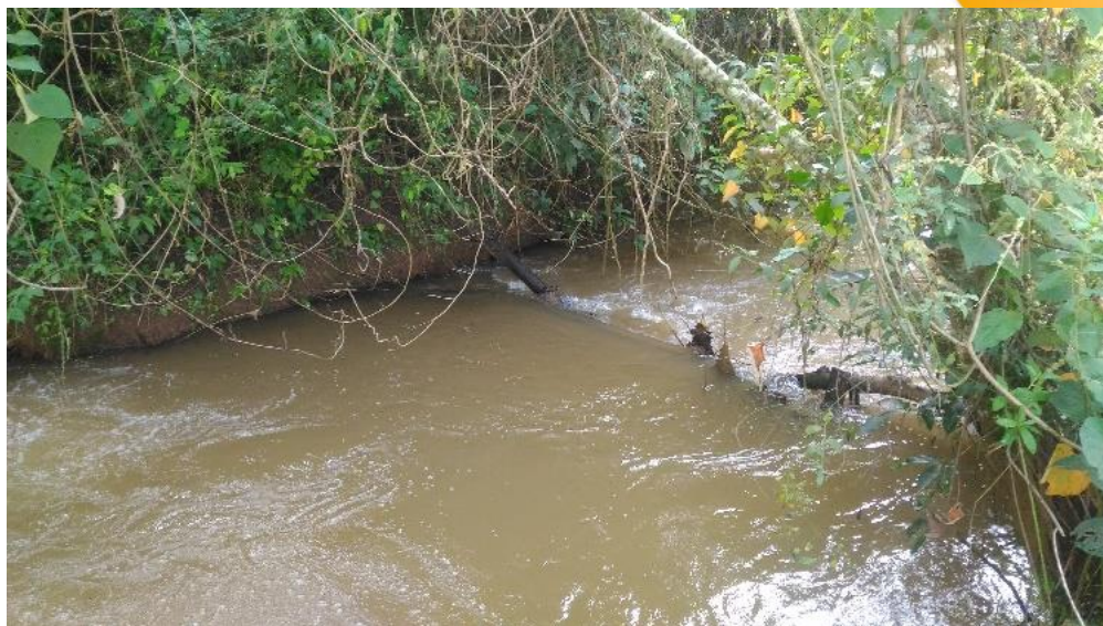
Figura 27 - Captação de água no Ribeirão Santa Bárbara
